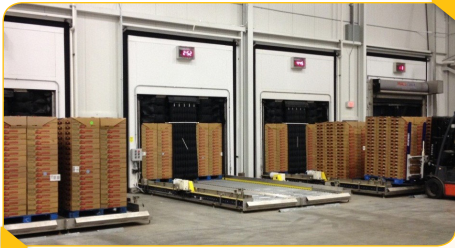
شکل ۶- انتقال محصول برداشت شده به انماک‌های پیش‌سرما مجهز به سیستم اتوماتیک هوای سرد پرفشار
